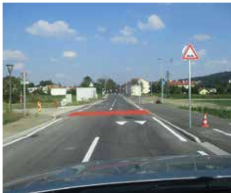
Foto: Komplett sanierte Franz-Weymann-Gasse
