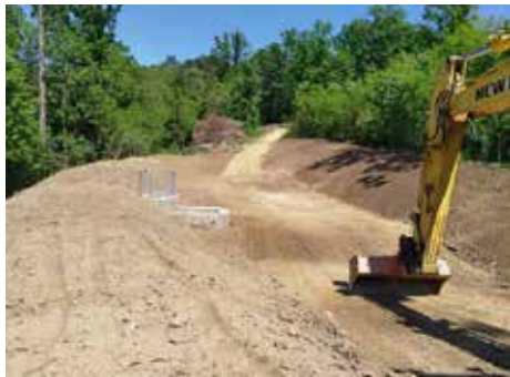
Foto: © R. Sitz, Fertiggestelltes Becken im Bereich Gamshöhe
