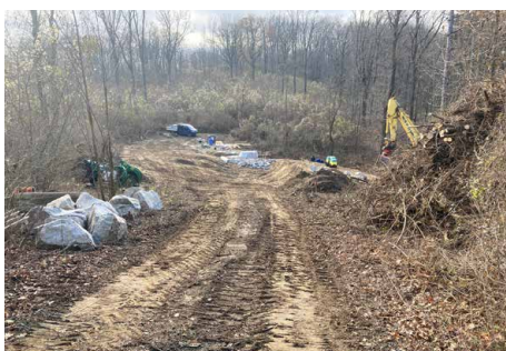
Foto: © R. Sitz, Blick von der Bergstraße auf die Baustelle (Stand 24.11.21)
