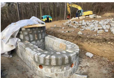
Foto: © R. Sitz, der fertiggestellte Ablaufregler („Mönch“) im Becken „Gamshöhe“
