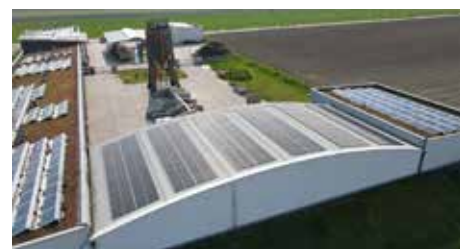
Foto: Paneelen am Dach des Bauhofs
