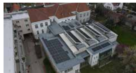
Foto: Dach der Volksschule Bisamberg
