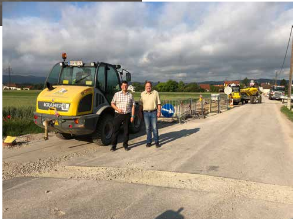
Foto: Sanierung der gesamten Franz-Weymann-Gasse
