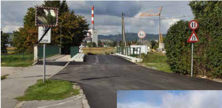
Foto: Abgeschlossene Sanierung der Brücke Franz-Weymann-Gasse
